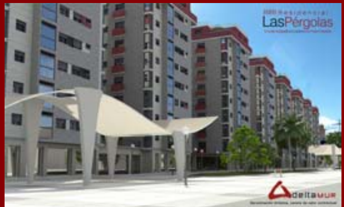
Panorámica del conjunto
